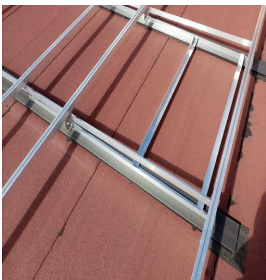
ryc. przykładowe mocowanie konstrukcji nosnej aerodynamicznej z przykładowym rozkładem elementów balastowych
