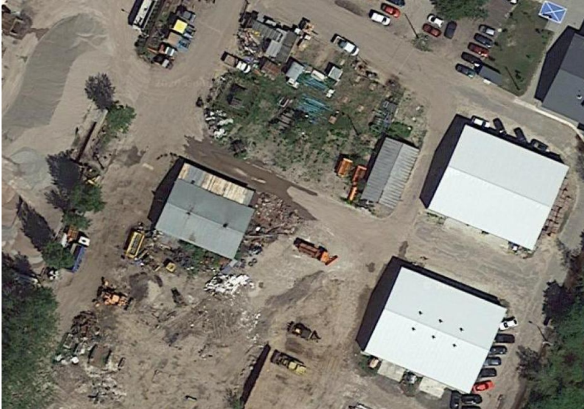
ryc. miejsce montażu generatorów fotowoltaicznych - budynki magazynowe z dachami dwuspadowymi o jasnym zabarwieniu - pokrycie blacha trapezowa ocynkowana
